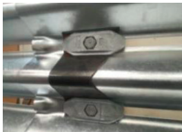
Pièce au droit des coulisses de glissières
